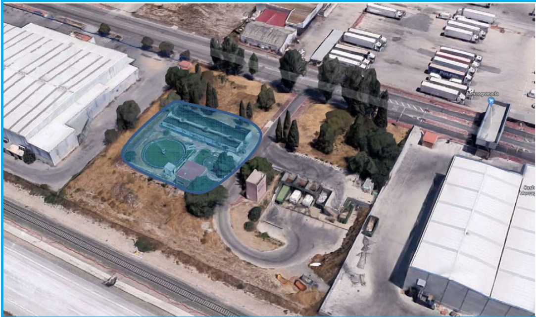
Situación EDAR actual
