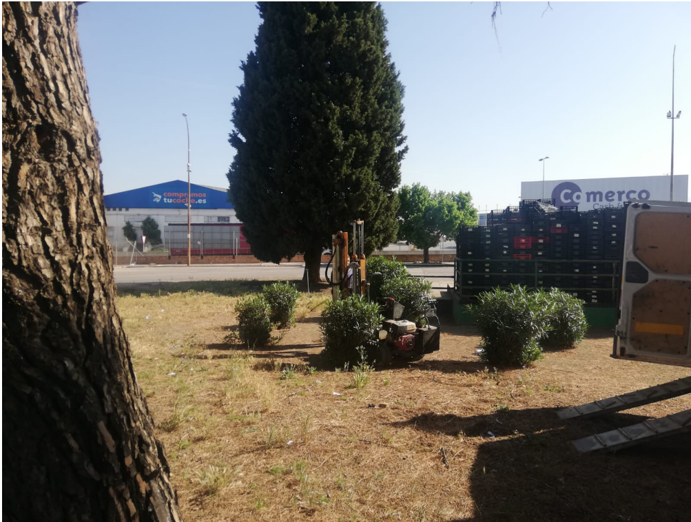
Foto 8.-Vista de máquina realizando ensayo de penetración Pd-4
