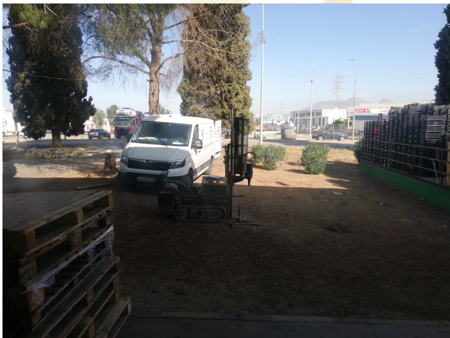
Foto 7.-Vista de máquina realizando ensayo de penetración Pd-3
