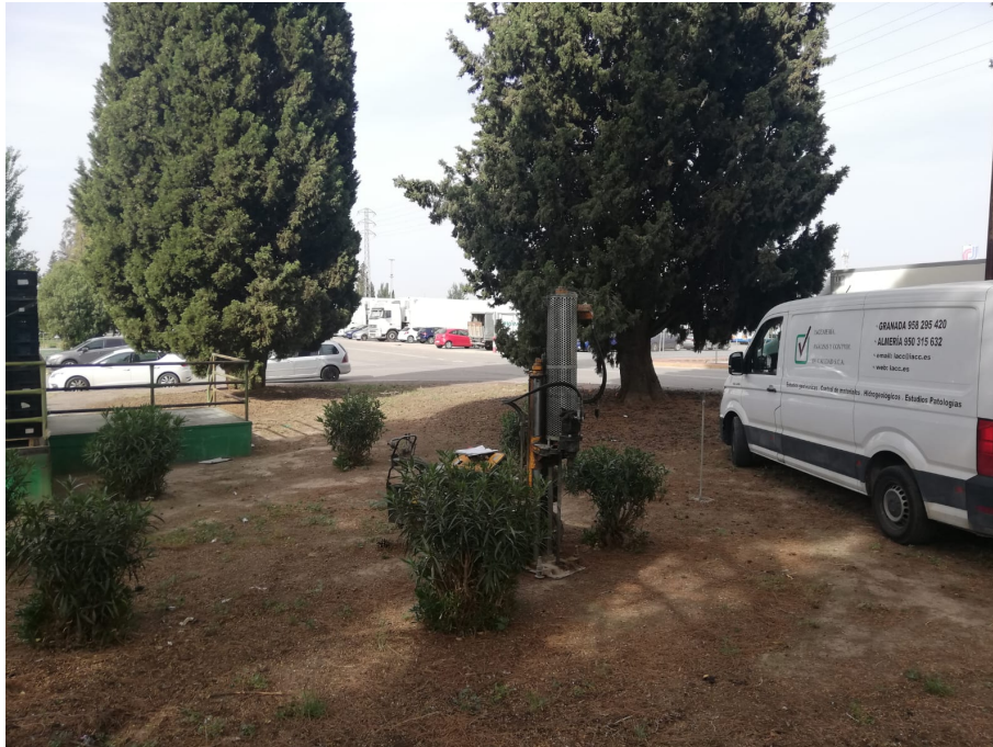
Foto 6.-Vista de máquina realizando ensayo de penetración Pd-2
